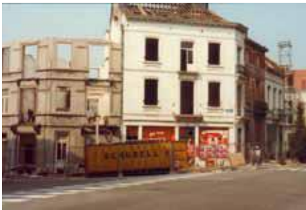
La démolition est en cours (1980)
