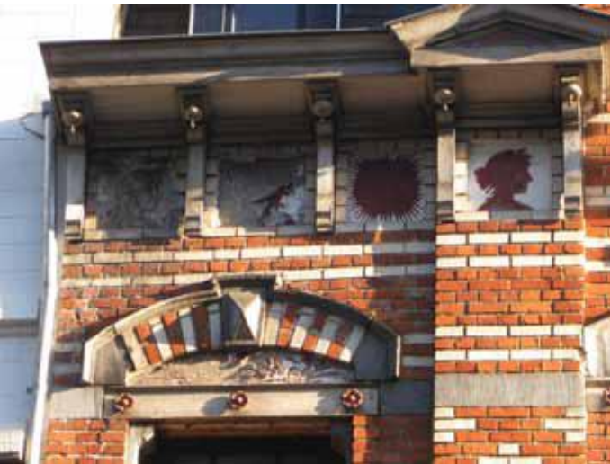
steiger voorgevel dag 1, 23 april 2009
