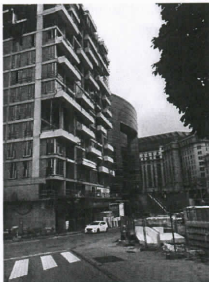
Figuur 10. Beeld nieuwbouw overzijde J. de Lalaingstraat.
