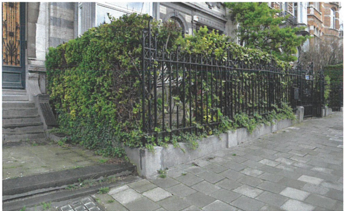
49. Grilles de clôture des propriétés mitoyennes.
