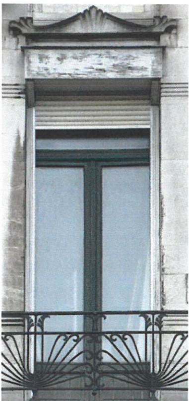
69. Fenêtres du premier étage.
