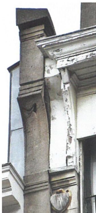
74. Éléments subsistants de la corniche, en partie masqués par des panneaux.
