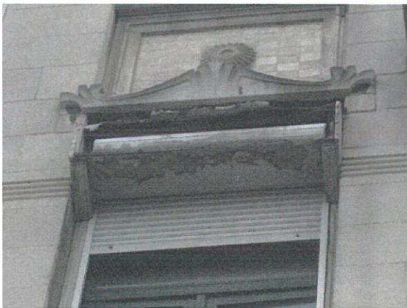
Caissons à volets non d'origine
