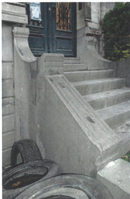
53. Perron. 2 et 3. Marche du palier du perron plus récente, avec ciselure périphérique différente de celle des marches inférieures, ayant remplacé l'originelle, percée d'une ouverture ; 4 : traces de rebouchage d'une rampe plus récente fixée au parapet gauche du perron.
