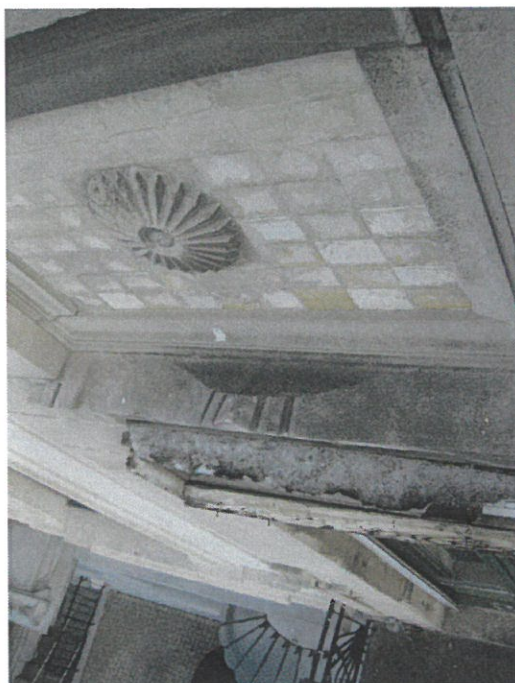
Damier de briques blanches et jaunes – peintes ? - d'allèges de châssis - Etat des briques de Silésie et joints de la cheminée
