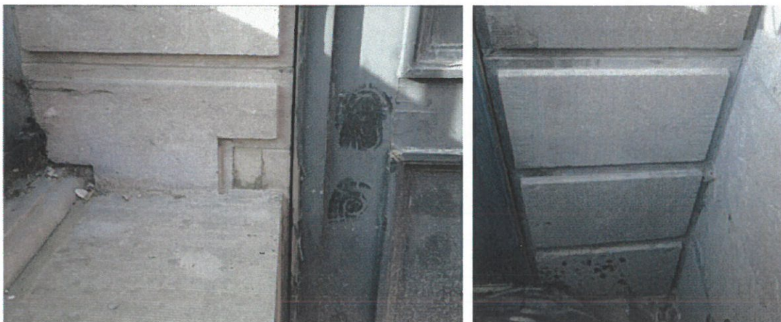
59-61. Soubassement en pierre bleue à bossages. En bas, à gauche, on observe la découpe pratiquée dans un bossage du trumeau pour recevoir l'extrémité du seuil de la fenêtre d'origine.
