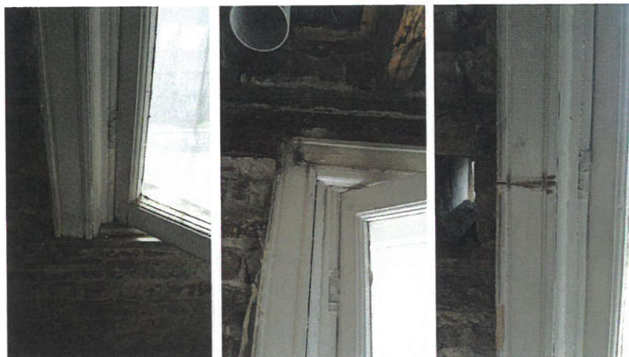
C31 – C32 – C33 : état des ébrasements et chambranles à restaurer
