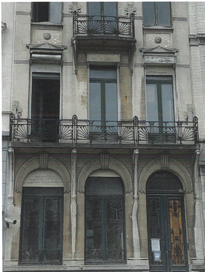
Etat général des ferronneries existantes
