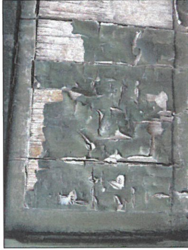
Etat catastrophique des finitions et du support de la porte d'entrée
