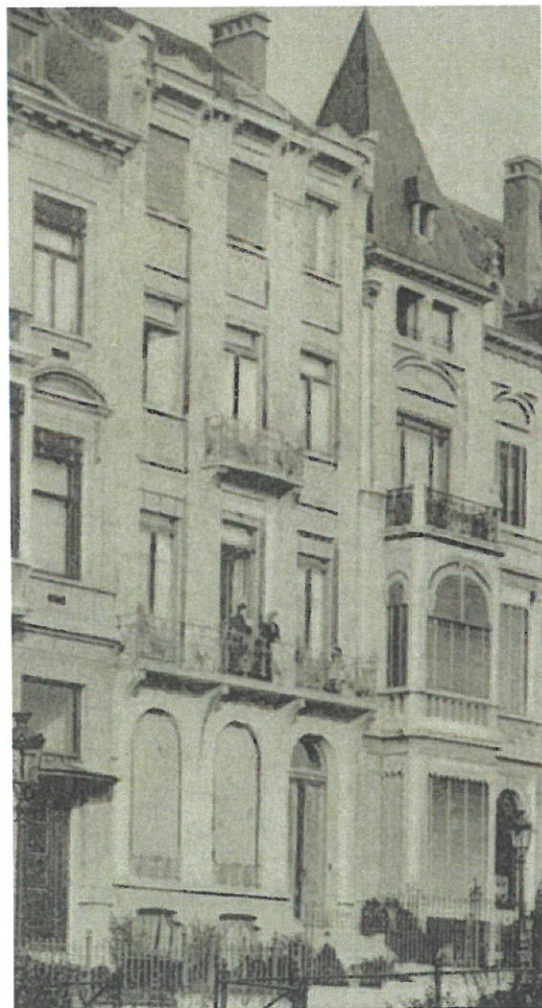
25. Vue du côté pair de l'avenue Palmerston, en direction du square Ambiorix. Photo prise entre 1902, après l'installation de La Folle Chanson , sculptée par Jef Lambeaux, au centre de l'avenue, et 1907, avant la construction de l'ensemble, à l'angle de l'avenue et du square Ambiorix. Carte postale (Collection Belfius Banque © ARB-SPRB). ; 26. Détail : n° 18.
