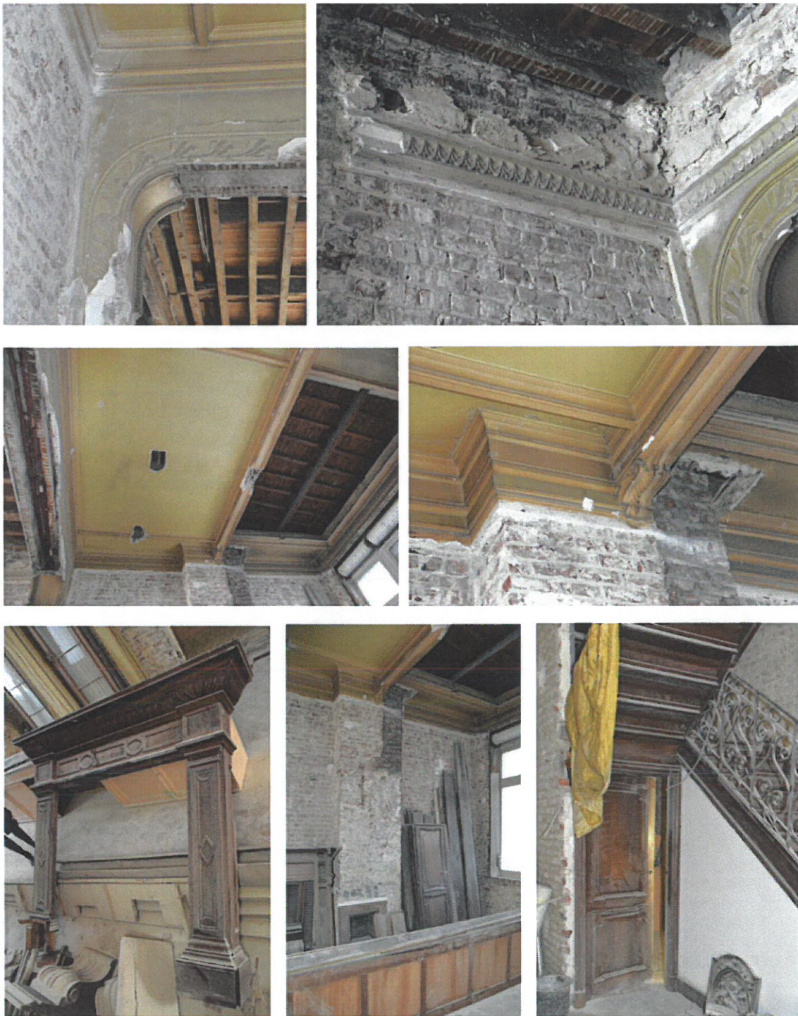
79. En haut et au milieu, restes de moulures typiques des intérieurs de Govaerts. La trémie de la verrière de la véranda a été fermée par une toiture plate.
