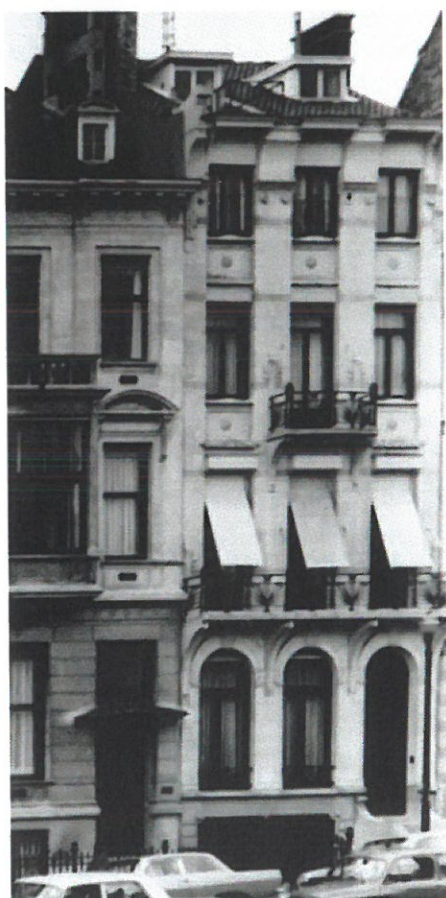
43 et 44. AVB/TP 83034 (1968). Nos 6 et 8 avenue Palmerston. Transformations intérieures et extérieures. Photo accompagnant la demande de permis de bâtir. En bas, détail : n° 18.
