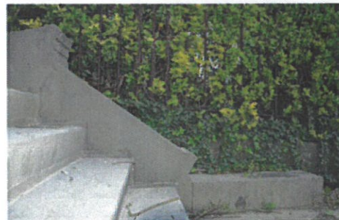
53. Perron. 2 et 3. Marche du palier du perron plus récente, avec ciselure périphérique différente de celle des marches inférieures, ayant remplacé l'originelle, percée d'une ouverture ; 4 : traces de rebouchage d'une rampe plus récente fixée au parapet gauche du perron.
