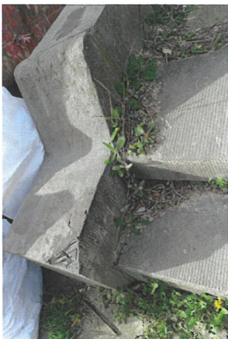
50. Nouvelles marches en pierre bleue à l'entrée de « l'allée ». Partie avant du bloc à front d'alignement, entaillée pour permettre l'ancrage du portillon. Traces visibles du rebouchage de l'ancrage.
