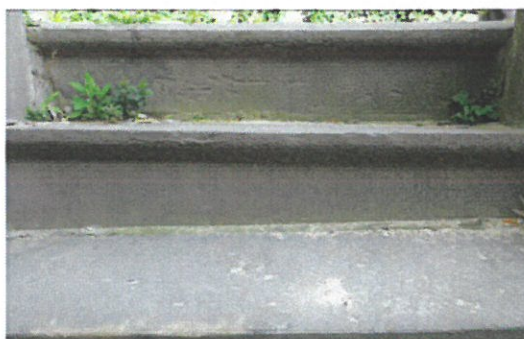
51. trois marches entre « l'allée » et le passage. La marche inférieure, récente, a été placée pour rattraper le dénivelé de la rampe du garage.
