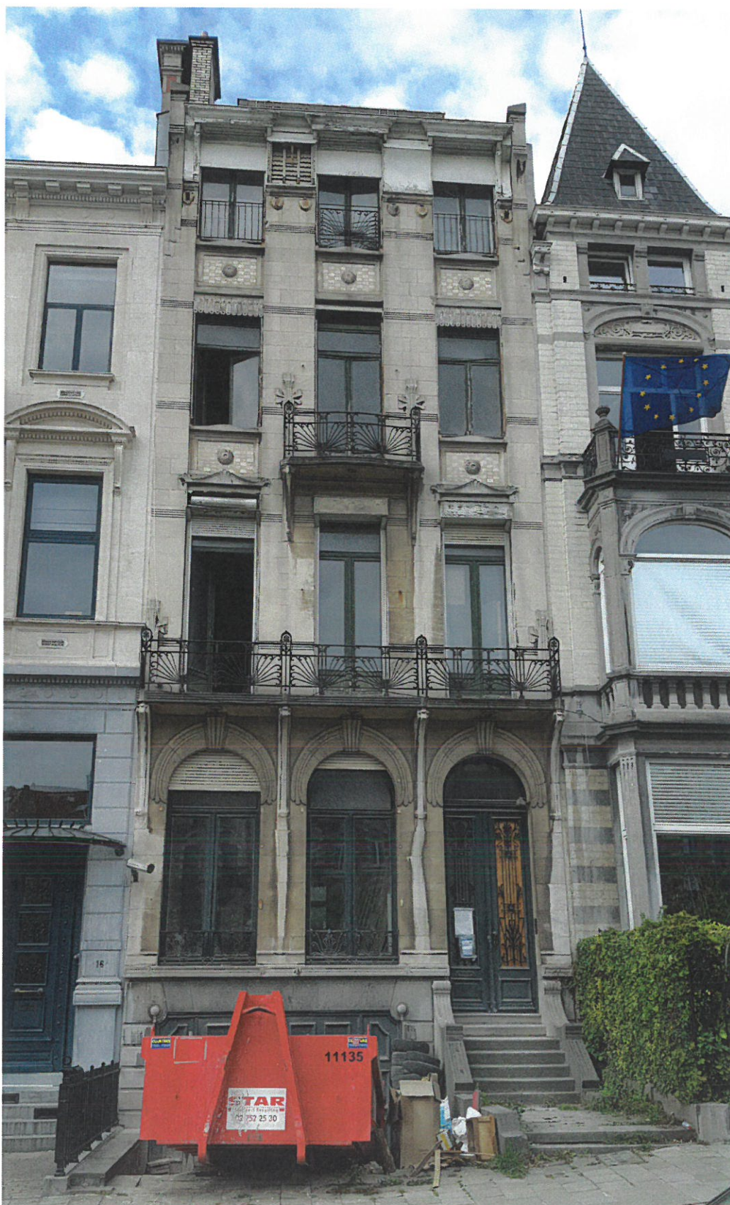
Etat général de la façade
