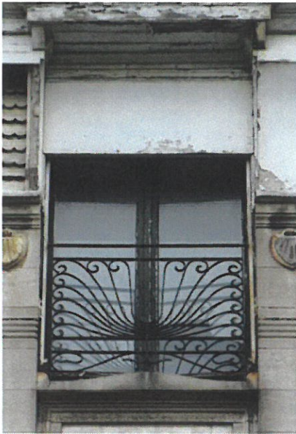
72. Fenêtre du troisième étage. Elle est précédée d'une grille se trouvant à l'origine devant la fenêtre gauche du deuxième étage. À droite : fenêtre doublée par un châssis intérieur.
