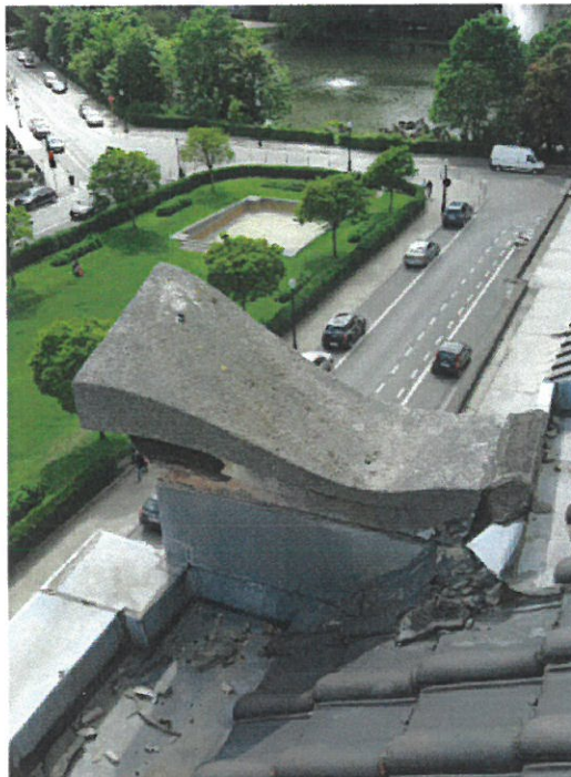
Etanchéité en zinc placée après suppression des frontons en bois peint (+-1970)
