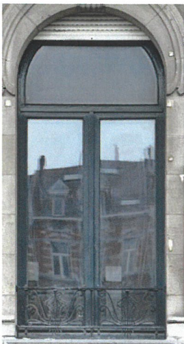
68. Fenêtre du rez-de-chaussée.
