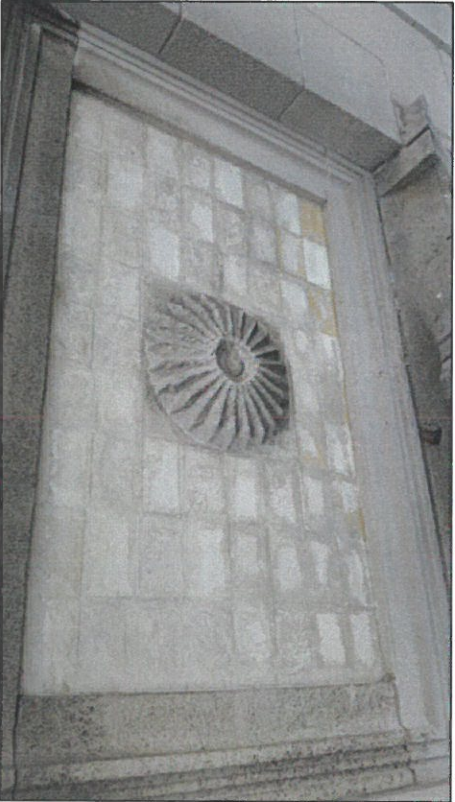
Partie supérieure de la façade avec le décor des allèges. Des panneaux rectangulaires sont venus ultérieurement masquer les lambrequins des jalousies (Photo APEB)
