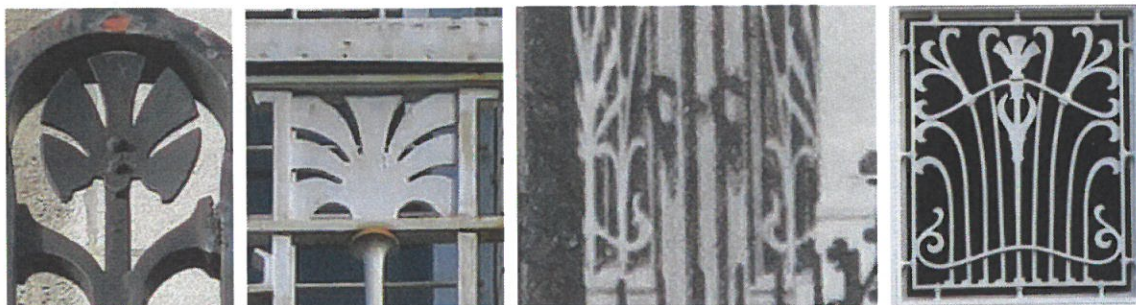
1 | 2 | 3 | 4 Fig. 23. 1 et 2 : palmette en tôle de fer, à gauche : av. Palmerston 18 et à droite : rue Franklin 126 (1899) ; 3 : porte d'entrée de l'av. Palmerston 18, avec deux ouvrants, chacun pourvu d'une poignée ;
