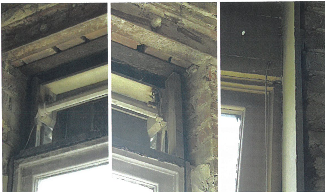
Mécanisme des jalousies extérieures d'origine – vues intérieures 2EM étage
