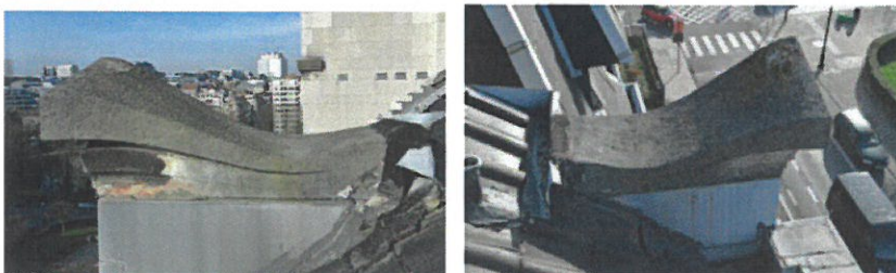
75. Versant avant de la toiture, avec souche de cheminée d'origine et lucarne aménagée à la fin des années 1960 ou dans les années 1970. En bas, amortissement en pierre des acrotères ornant les extrémités de la façade.
