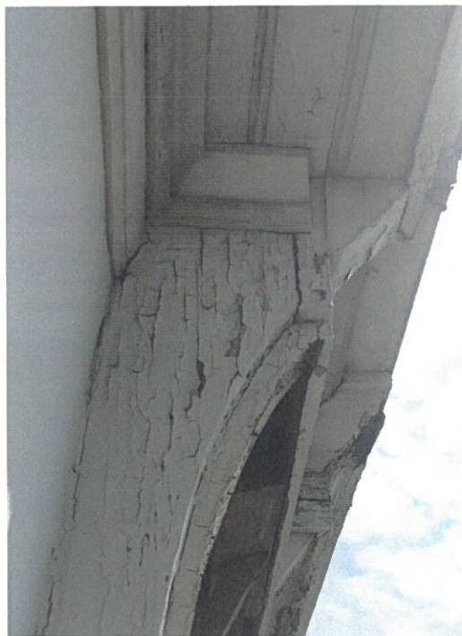
Consoles « rabotées » pour habillage en panneaux de multiplex: en pied et en tête
