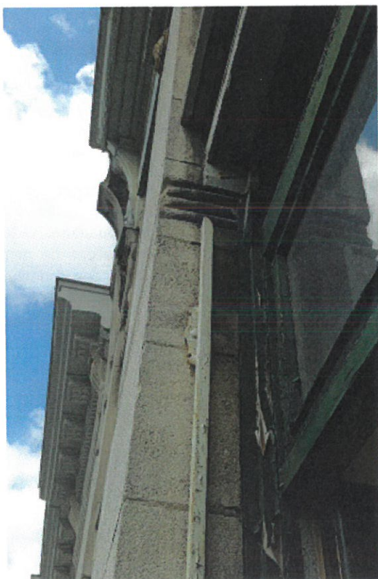
Système de guidage par profil en fer forgé ancrée sur l'ébrasement en pierre et par une pièce en bois rapportée sur le dormant du châssis
