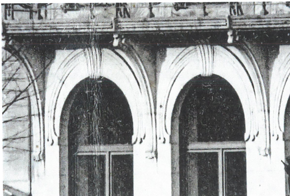
23. Idem. Baies du rez-de-chaussée du n° 18 et détail de leur arc.
