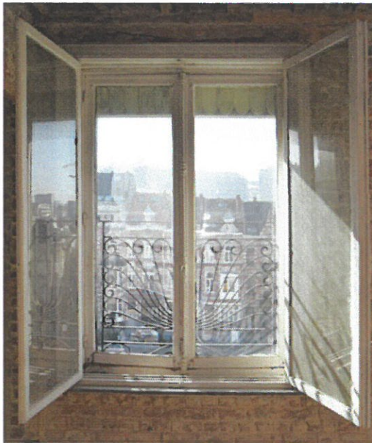
72. Fenêtre du troisième étage. Elle est précédée d'une grille se trouvant à l'origine devant la fenêtre gauche du deuxième étage. À droite : fenêtre doublée par un châssis intérieur.
