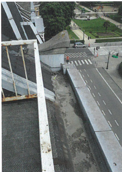
Etanchéité en zinc placée après suppression des frontons en bois peint (+-1970)
