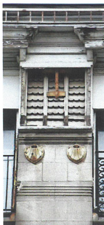
74. Éléments subsistants de la corniche, en partie masqués par des panneaux.
