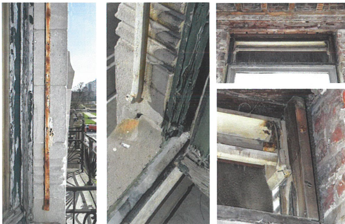
71. Mécanisme de la jalousie d'une fenêtre du deuxième étage.
