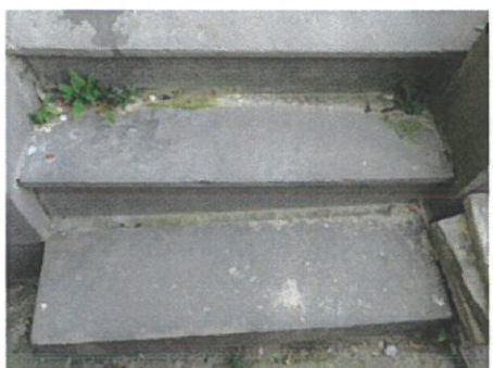
51. trois marches entre « l'allée » et le passage. La marche inférieure, récente, a été placée pour rattraper le dénivelé de la rampe du garage.
