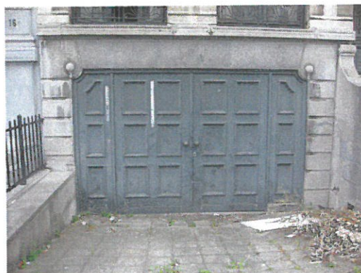
Etat général du soubassement et de la rampe
