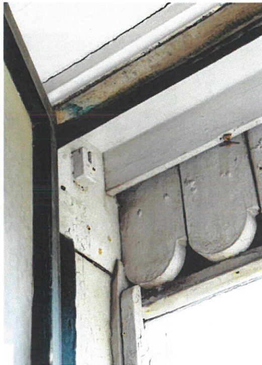
72. Fenêtre du troisième étage. Elle est précédée d'une grille se trouvant à l'origine devant la fenêtre gauche du deuxième étage. À droite : fenêtre doublée par un châssis intérieur.
