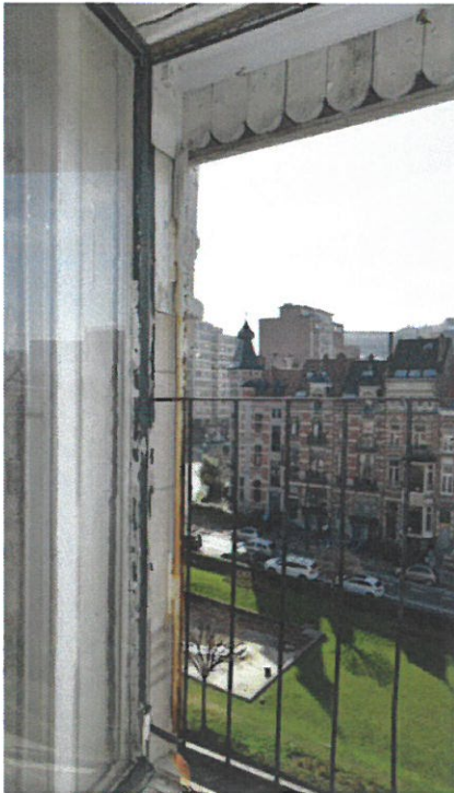
73. Le lambrequin et une partie du dispositif de jalousie en place.
