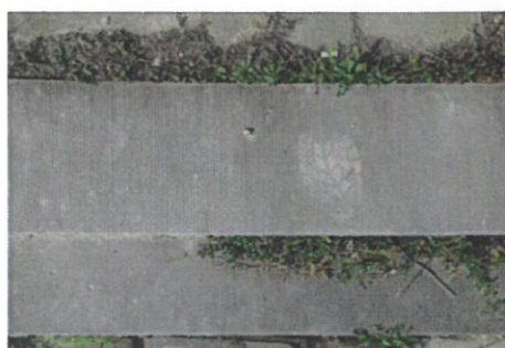
50. Nouvelles marches en pierre bleue à l'entrée de « l'allée ». Partie avant du bloc à front d'alignement, entaillée pour permettre l'ancrage du portillon. Traces visibles du rebouchage de l'ancrage.
