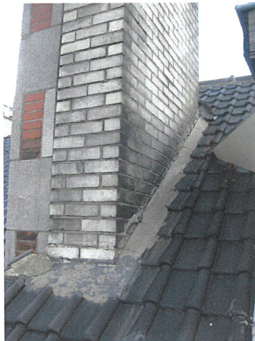
Damier de briques blanches et jaunes – peintes ? - d'allèges de châssis - Etat des briques de Silésie et joints de la cheminée
