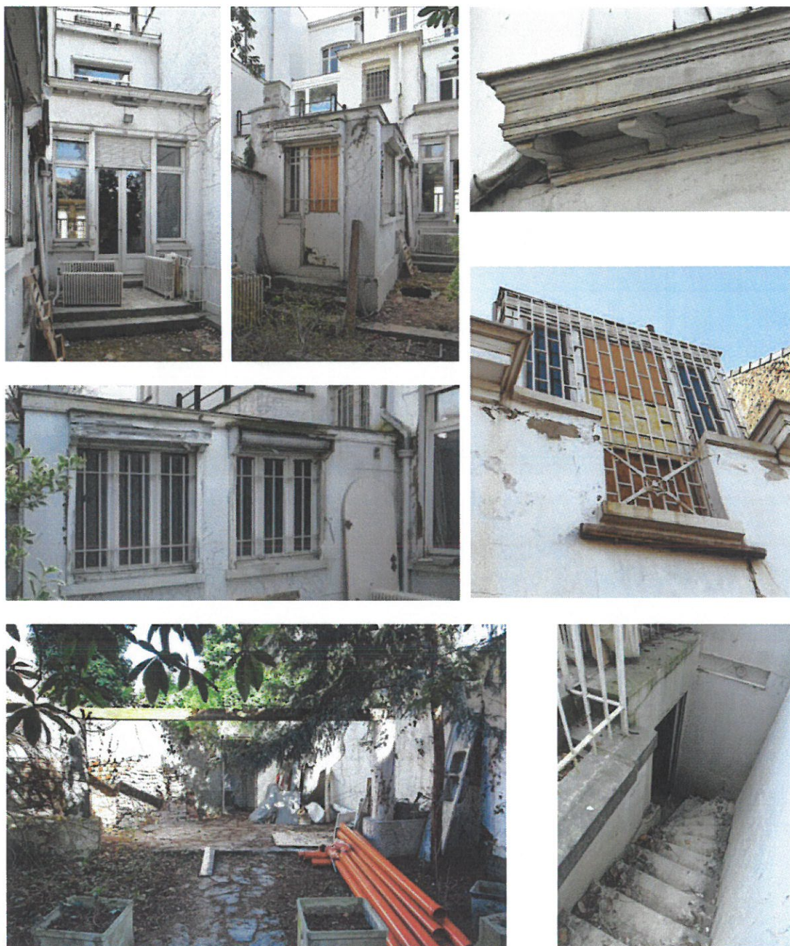
76. Façade arrière avec retraits successifs, annexe ajoutées en 1952, tout comme probablement la grande lucarne passante et la couverture de la cour basse par une dalle de béton.
