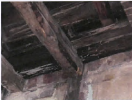
Foto 15: Dakgedeelte (J. Candon, 2007).
