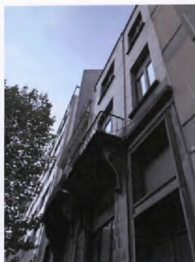
Foto 10: Voorgevel nr. 132 (ARCHEBO bvba, 19/09/2017).
