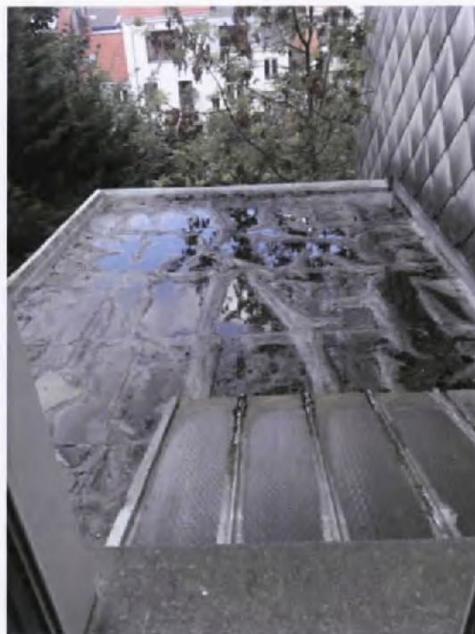
Plat dak badkamer nr. 132
