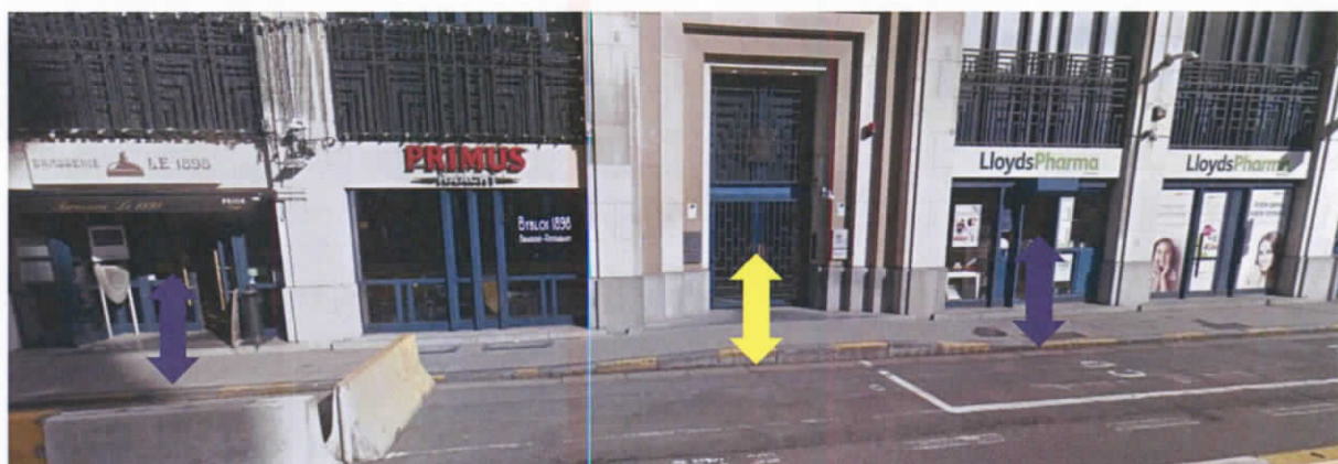
Figure 51 : Vue sur les différentes entrées du bâtiment avec la brasserie à gauche, l'entrée des bureaux au centre et la pharmacie à droite (ARIES, 2019)
