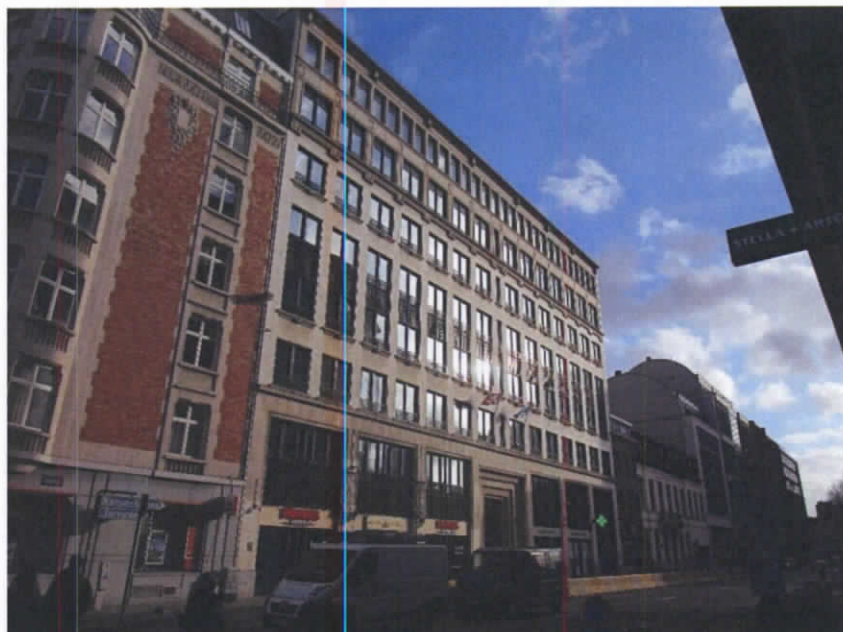
Figure 6 : Vue de l'immeuble concerné par la présente offre (ARIES, 2019)
