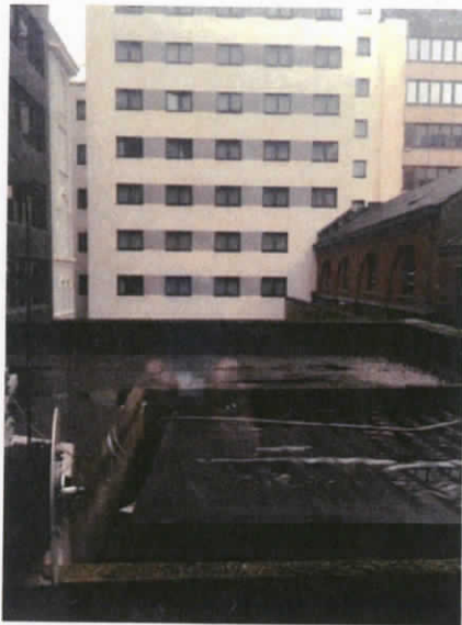
Construction en intérieur d'îlot
