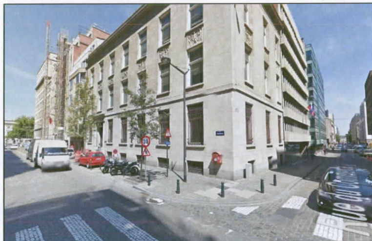
Figure 44 : Groupe d'arceaux pour vélos rue Montoyer (Source : A&B 2017)
