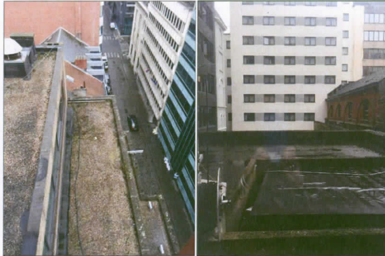
Figure 73 : vues des toitures des différentes toitures plates (Source : A&B 2017)
