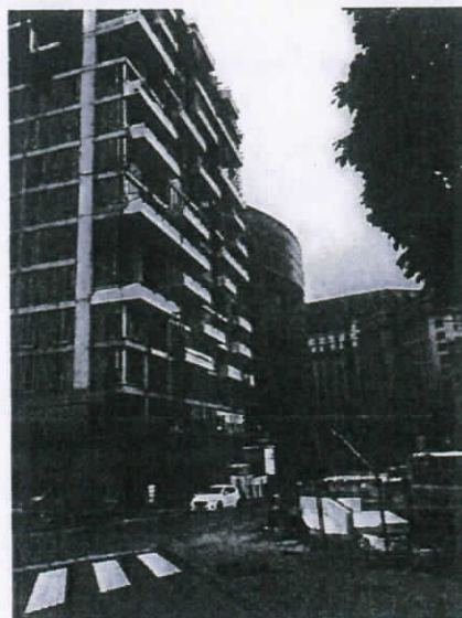
Figuur 10. Beeld nieuwbouw overzijde J. de Lalaingstraat.
