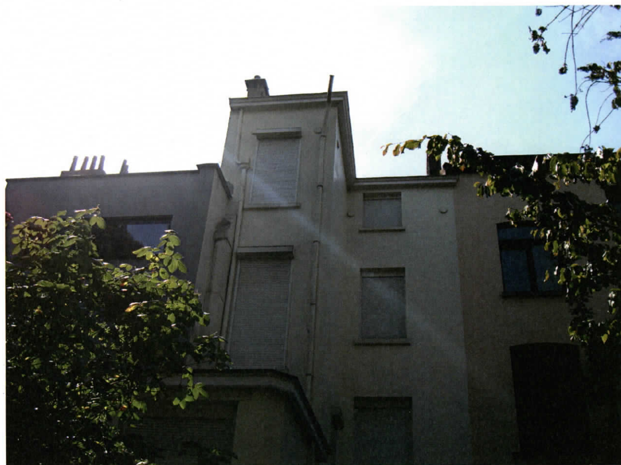
Photo n°8 – Façade arrière, vue maisons mitoyennes
