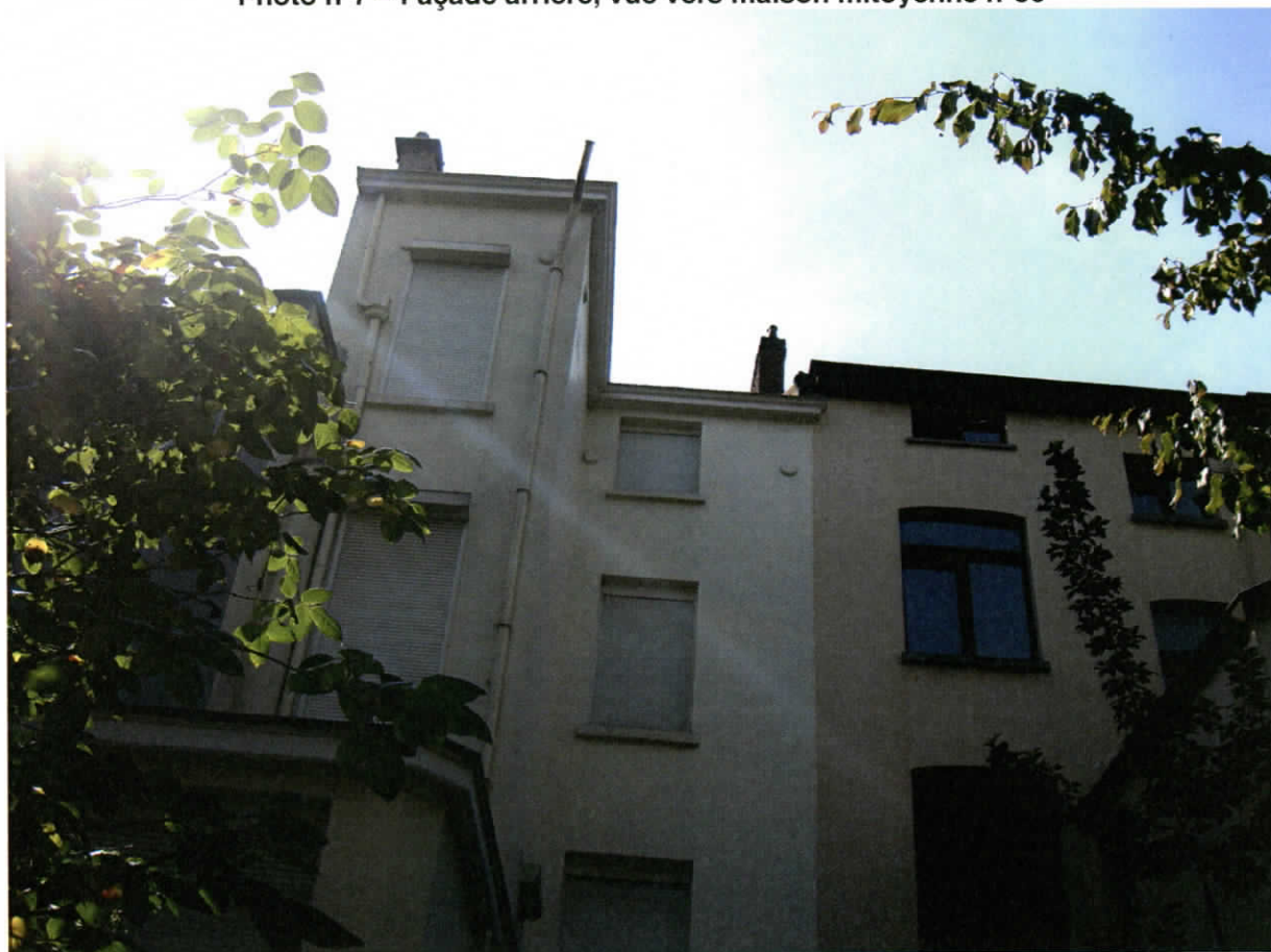
Photo n°7 – Façade arrière, vue vers maison mitoyenne n°30
