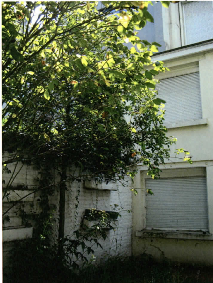
Photo n°11 – Facade arrière, vue vers mur mitoyen n°34
