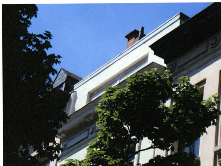
Photo n°2 – Façade à rue, vue vers lucarne
