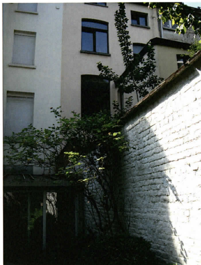
Photo n°12 – Facade arrière, vue vers mur mitoyen n°30
