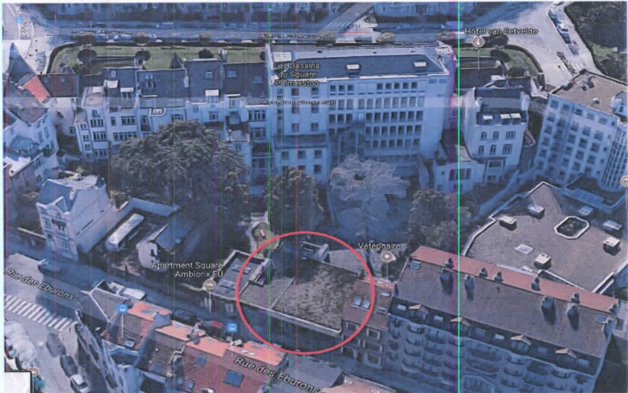
Bâtiment côté rue des Eburons
