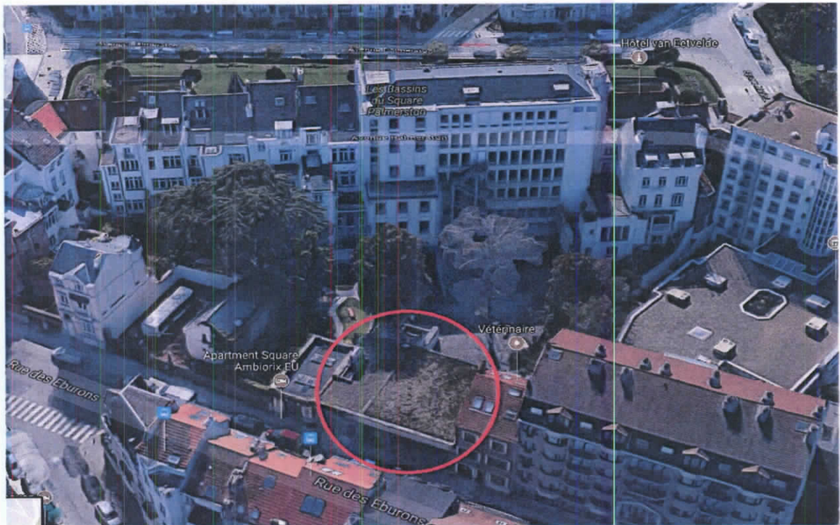
Bâtiment côté rue des Eburons
