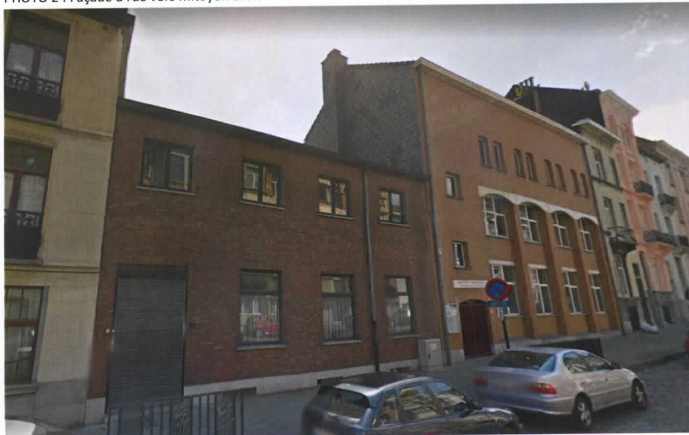
PHOTO 2 : Façade à rue vers mitoyen droit
