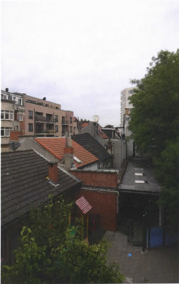
PHOTO 3 : Façade à cour depuis passerelle existante
