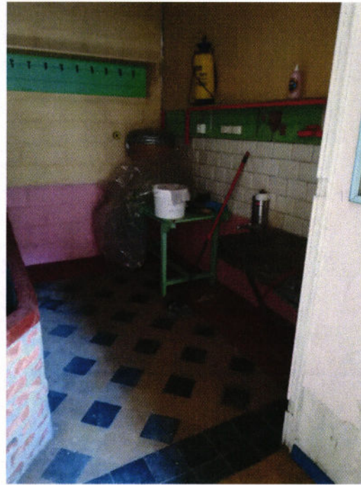
Photo n°54/ Rez-1 (sous-sol) - Chaufferie
