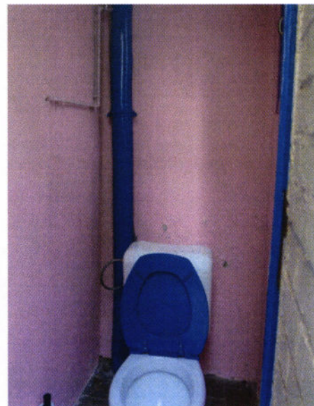
Photo n°58/ Wc (accès depuis cour)
