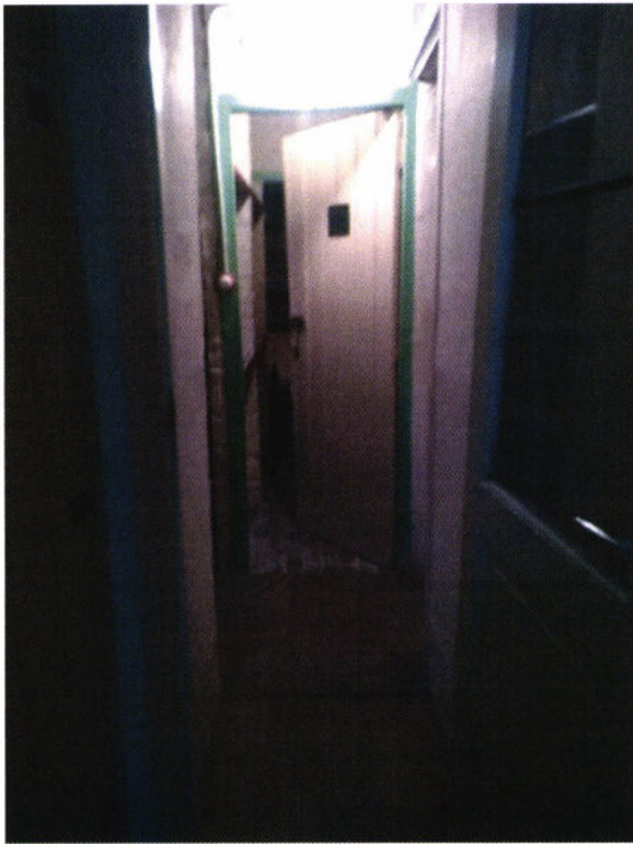
Photo n°50 Rez-1 (sous-sol) - Débarras
