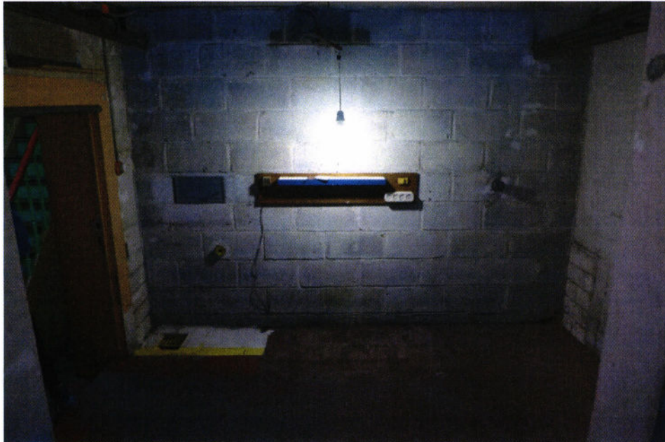
Photo n°47/ Rez-1 (sous-sol) - Garage
