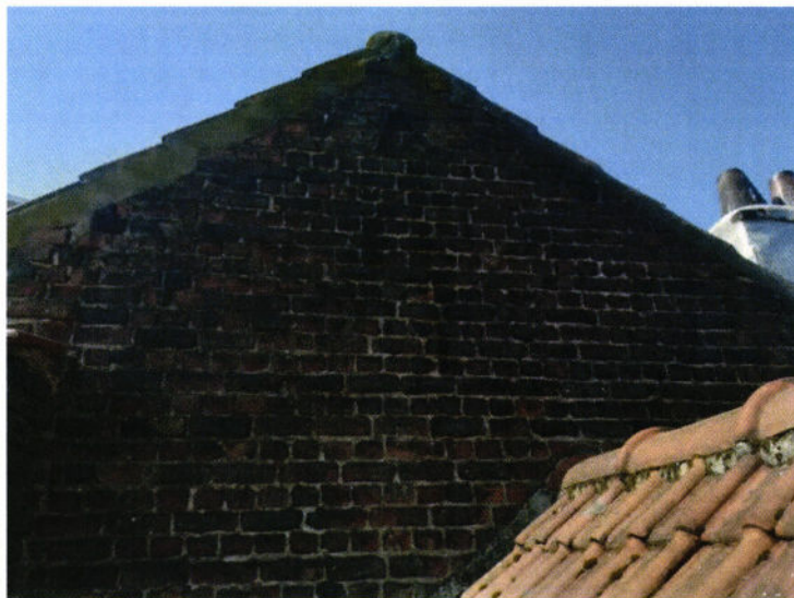
Photo n°44/ Toiture - côté voisin N°19
