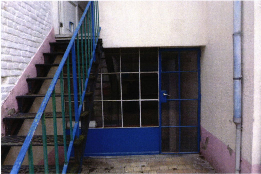
Photo n°56/ Rez-1 (sous-sol) - Chaufferie (vue de l'extérieur)
