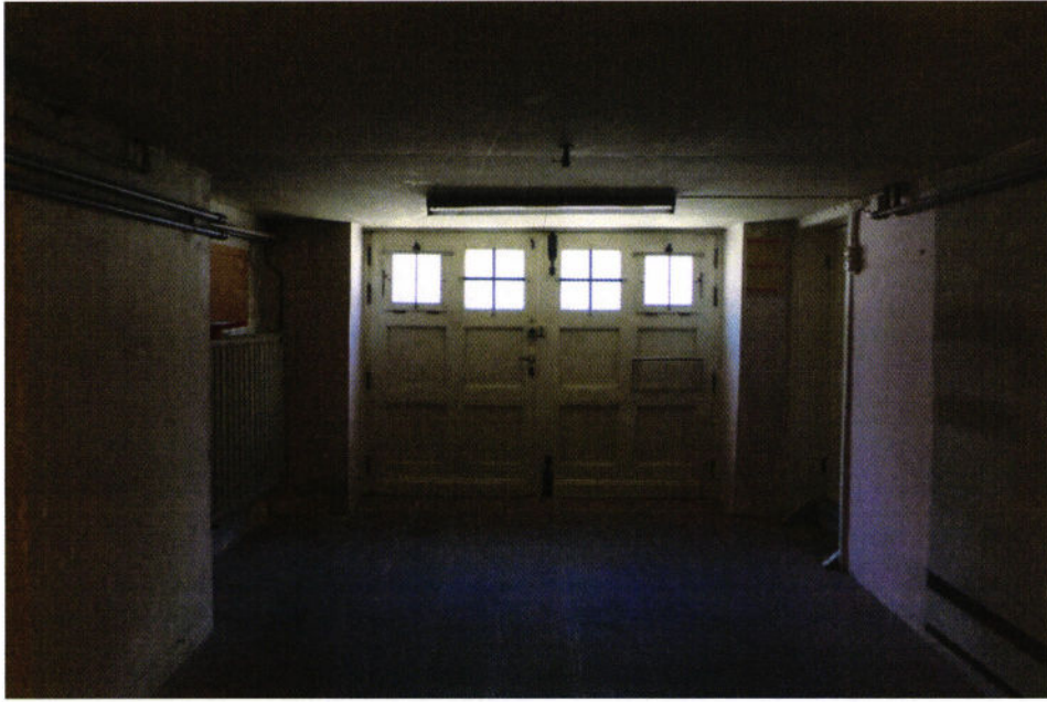
Photo n°46/ Rez-1 (sous-sol) - Garage
