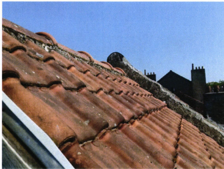
Photo n°43/ Toiture - côté voisin N°23
