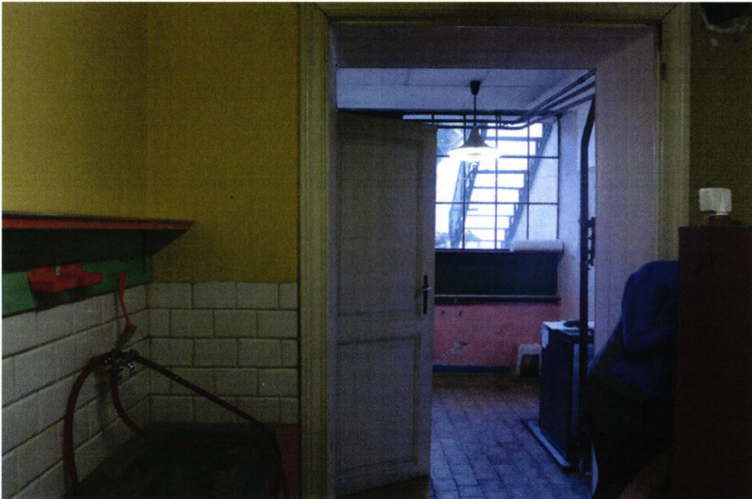
Photo n°55/ Rez-1 (sous-sol) - Chaufferie
