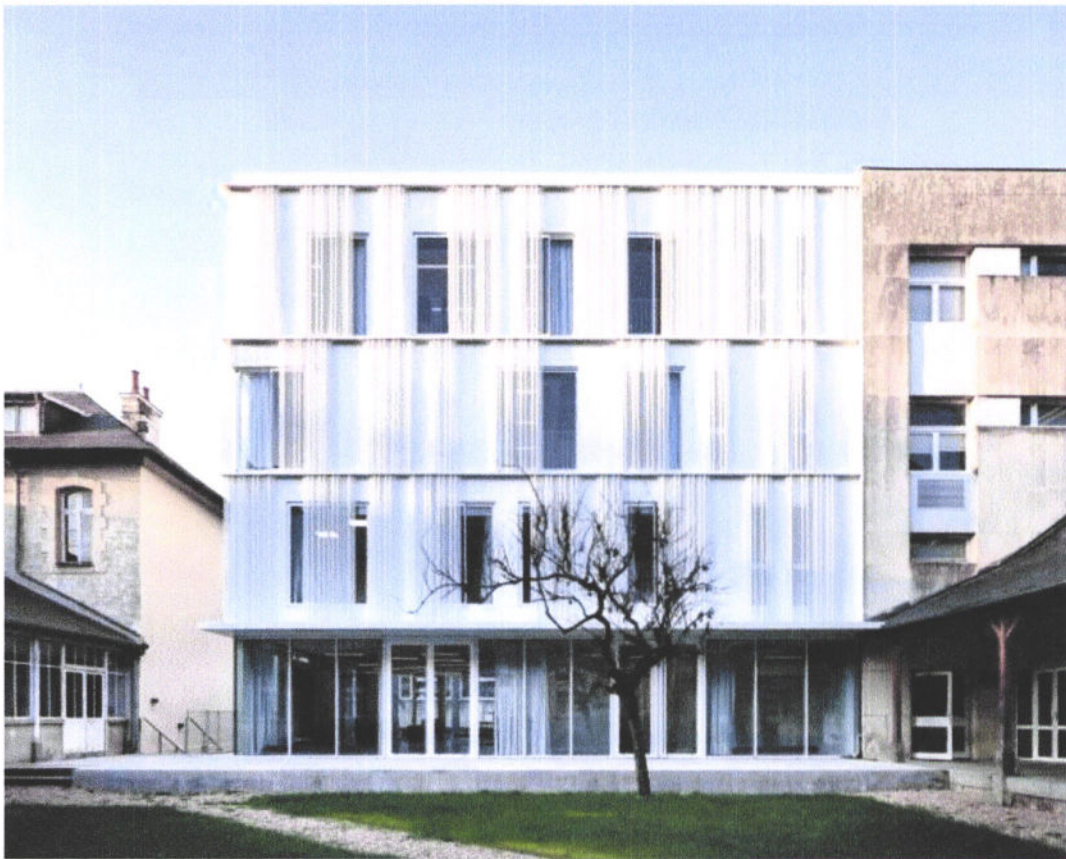
Référence Façade « Double peau/métal perforé » Rennes - Extension de l'université – LA Architecture.
