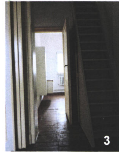
Accès grenier (3ème étage) - MODIFICATION
