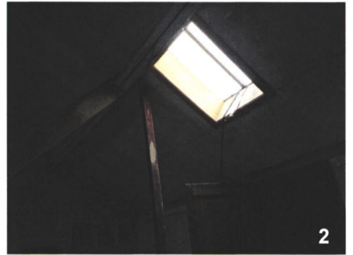
Ajout fenêtres de toits
