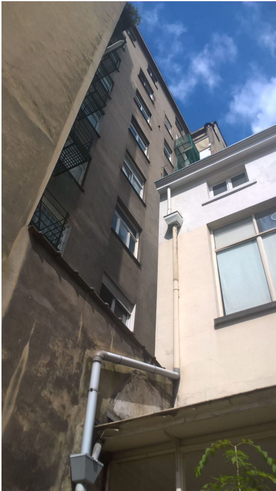
Photo 6: Vue de la niche dans le façade latérale de Avenue Marnix 19
