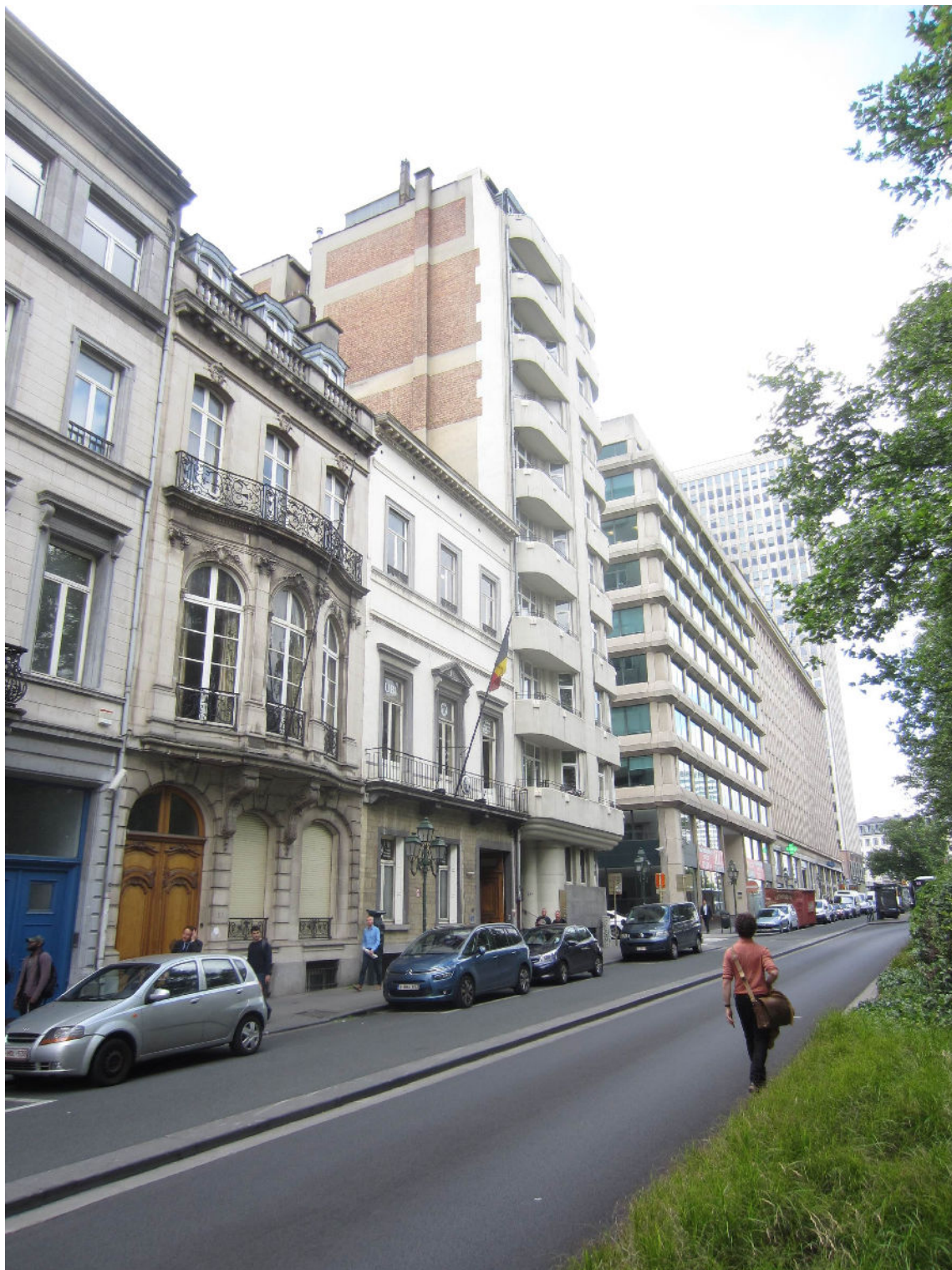
Photo 2: façade avec vue sur le voisin n ° 19
