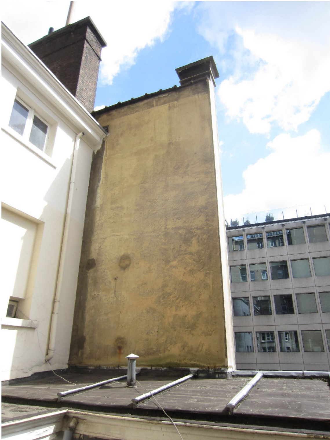
Photo 8: Vue de la façade latérale de Avenue Marnix 21
