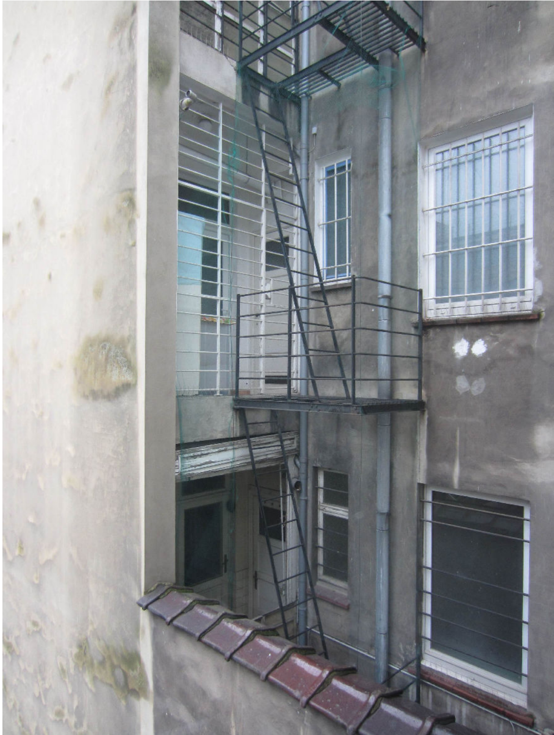
Photo 7: Vue de la niche dans le façade latérale de Avenue Marnix 19
