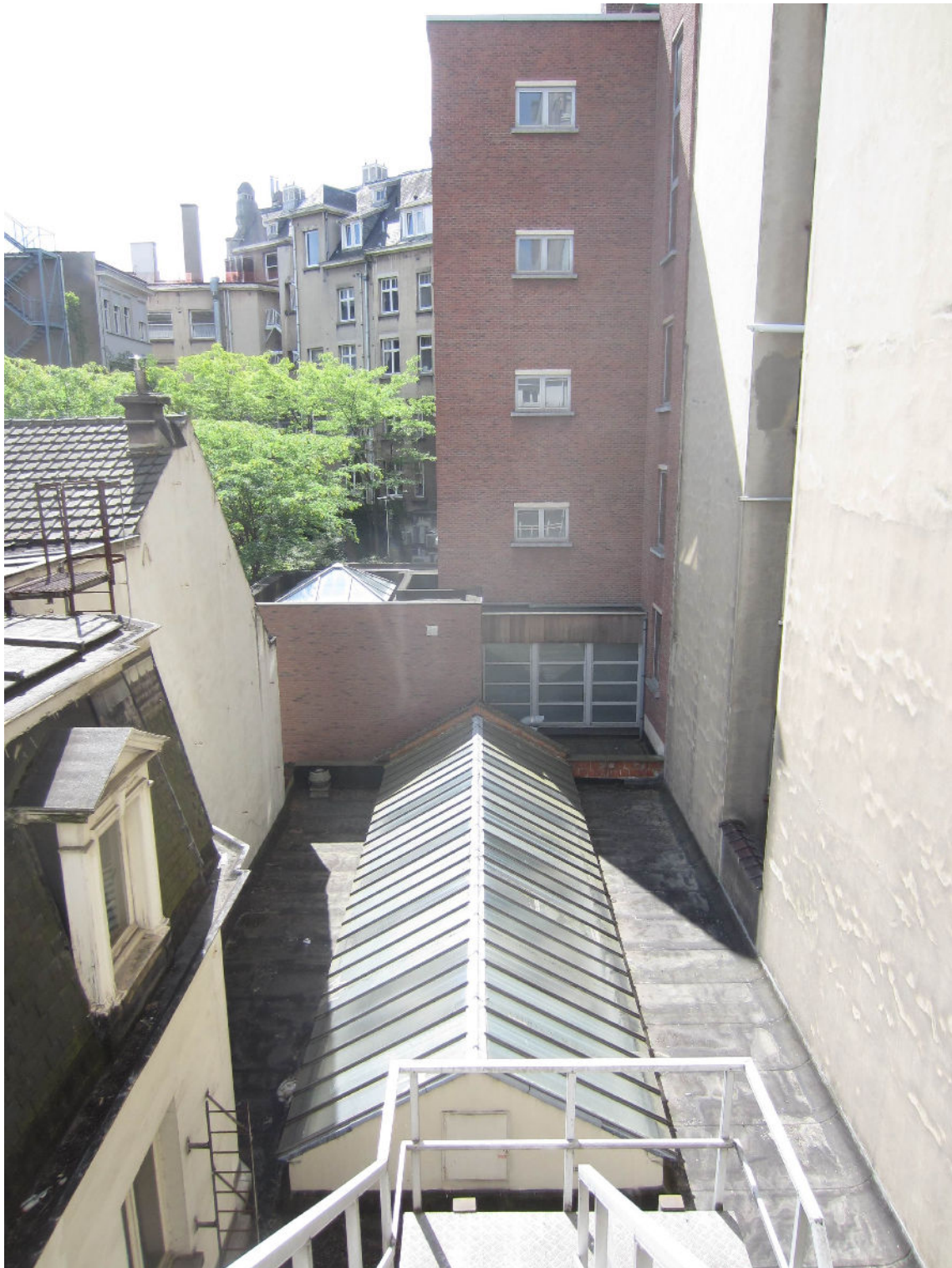
Photo 5: vue de la façade latérale Avenue Marnix n ° 19, 21 & Rue Des Hornes nr 4
