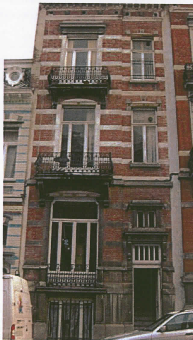
Situation après travaux
