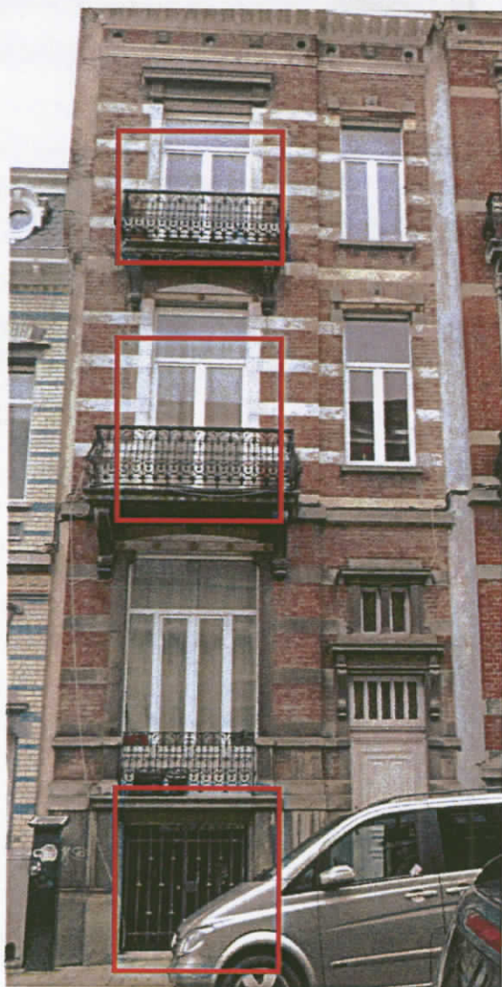
Situation avant travaux
