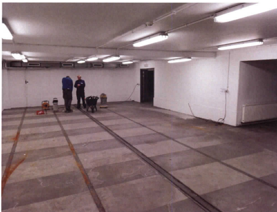
Photo 1 : Vue d'ensemble de la zone du piézomètre P1 (bâtiment sis rue de la Loi 95-97) (niveau -2), direction Ouest
