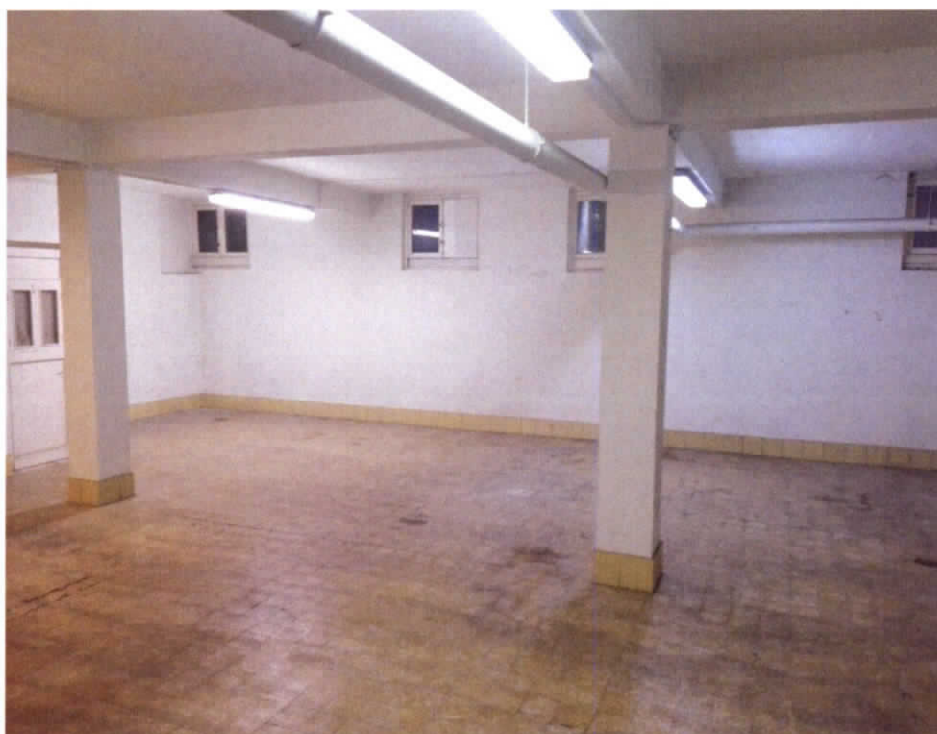
Photo 1 : Vue d'ensemble de la zone du piézomètre P3 (bâtiment sis rue de la Loi 91) (niveau -0,5), direction Sud
