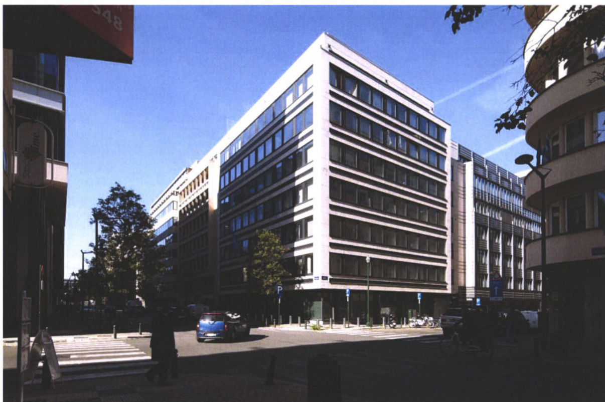
Image 08 : Photo de l'immeuble existant.
