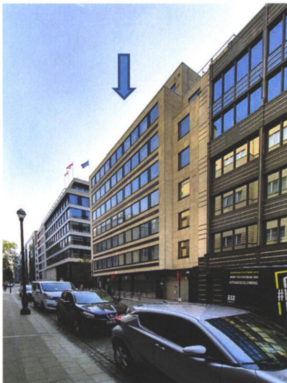
Photo 04 : Vue depuis la rue de l'Industrie - Façade Sud-Est – Industrie n°10
