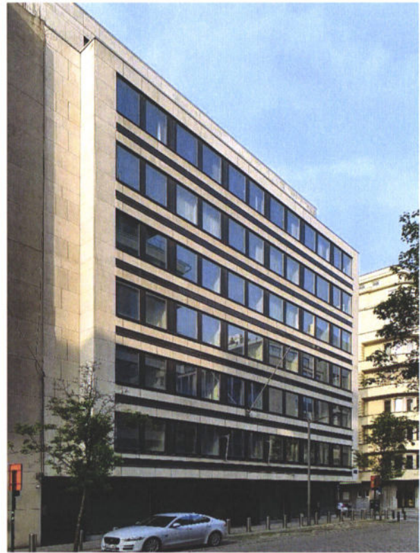
Photo 02 : Vue depuis la rue Montoyer - Façade Sud-Ouest
