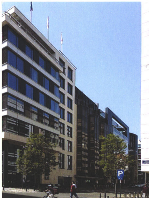
Photo 05 : Vue depuis l'angle Montoyer/Industrie – Industrie n° 6 et Montoyer n° 17-19
