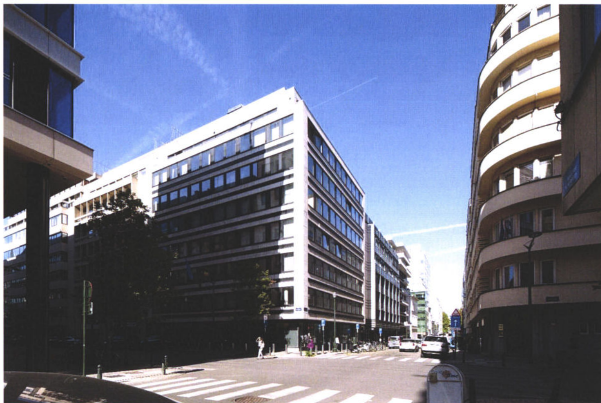
Photo 08 : Vue depuis la rue de l'Industrie
