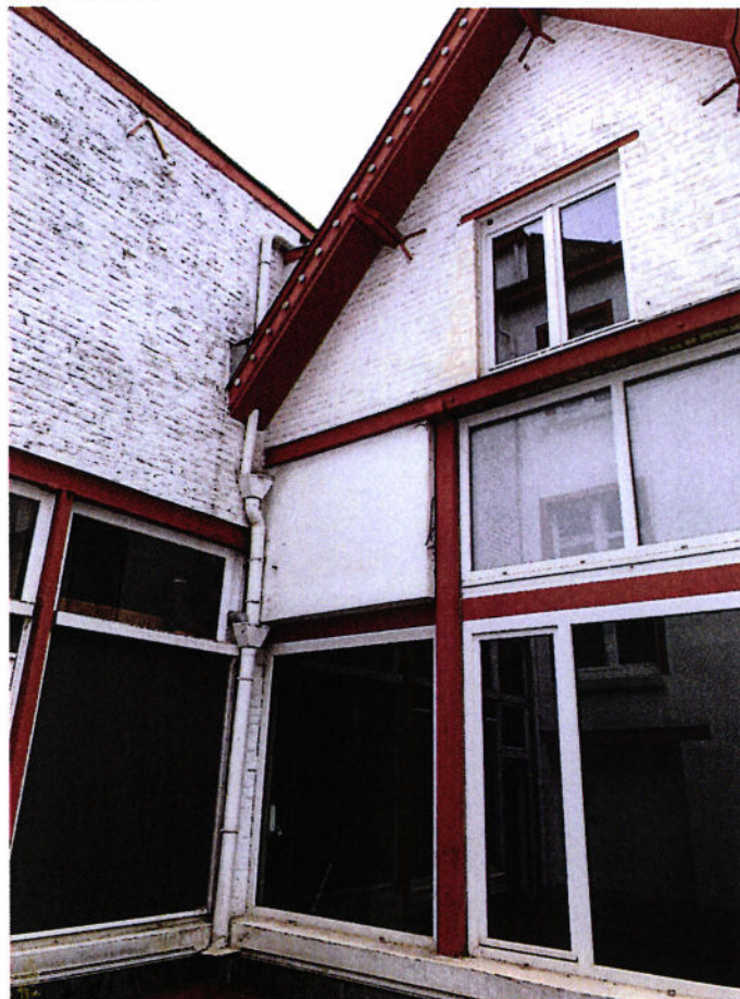
Photo 3 : façade n°31 atelier B et latérale A
