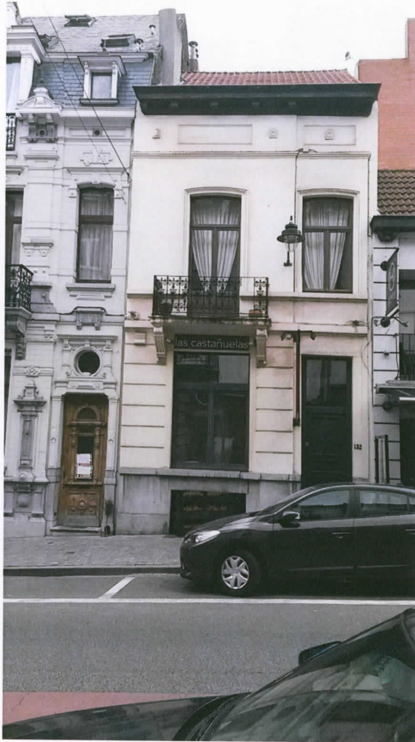
Photographie n°2 : façade avant. La demande vise également à la régularisation de l'enseigne
