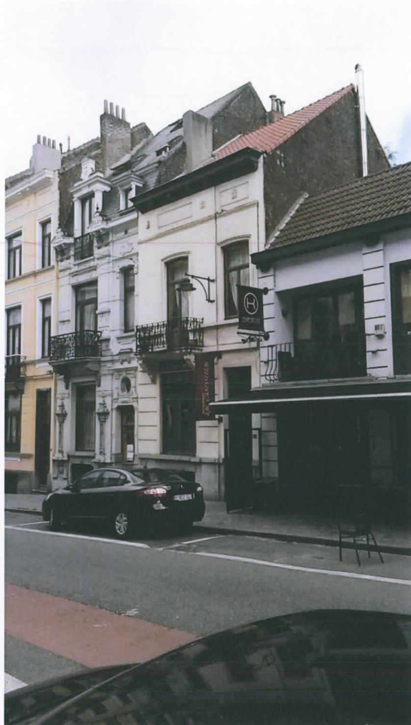
Photographie n°1 : façade avant. La demande vise également à la régularisation de l'enseigne
