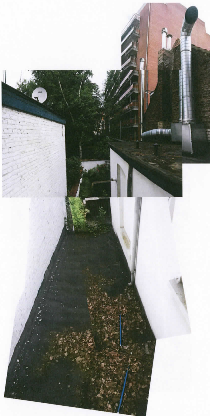
Photographie n°13 : vue vers la cour depuis le 1er étage
