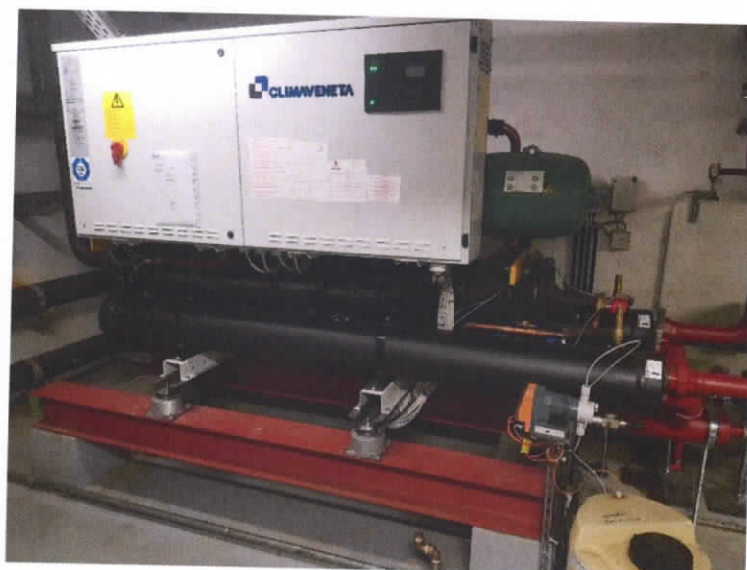
Figure 20: Groupe de production de froid
