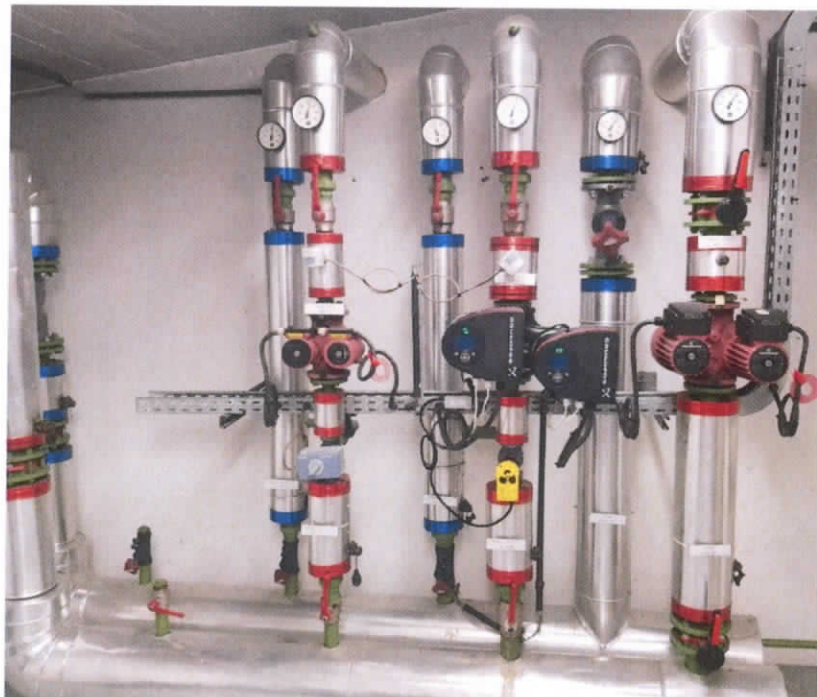
Figure 11: Isolation conduites de chaud.
