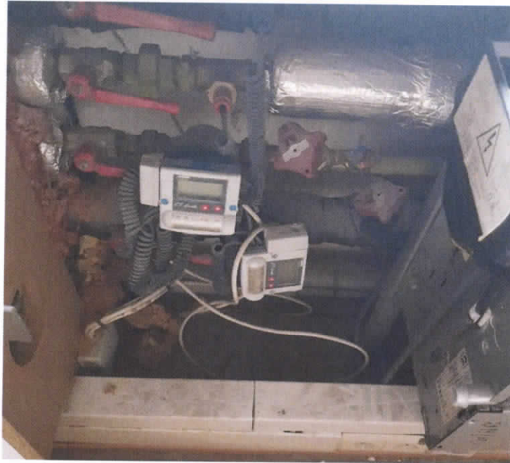
Figure 24: Thermostat d'ambiance par 2 ventilo-convecteurs
