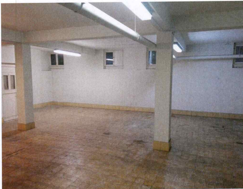
Photo 1 : Vue d'ensemble de la zone du piézomètre P3 (bâtiment sis rue de la Loi 91) (niveau -0,5), direction Sud
