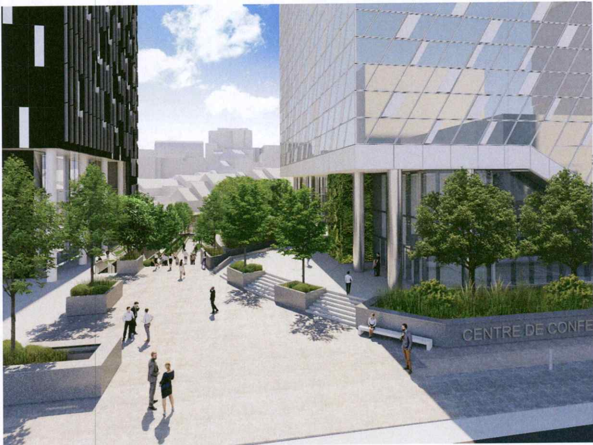
Figure 13.b : Vue vers le pocket parc à partir de la rue de la Loi – Projet amendé
