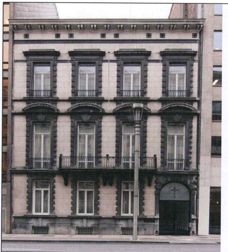
Photo – Façade classée (source : Registre du patrimoine immobilier protégé dans la Région de Bruxelles-Capitale)
